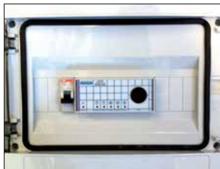
Telecontrollo installato nel quadro elettrico PVC in prossimità regolazione elettronica (per caldaie SERIE CND-GT3 – GT3 PLUS – 3GF)
