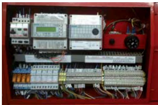
Telecontrollo installato nella regolazione elettronica di caldaia (per caldaie SERIE PMX – MDL – BOX – CTP)
